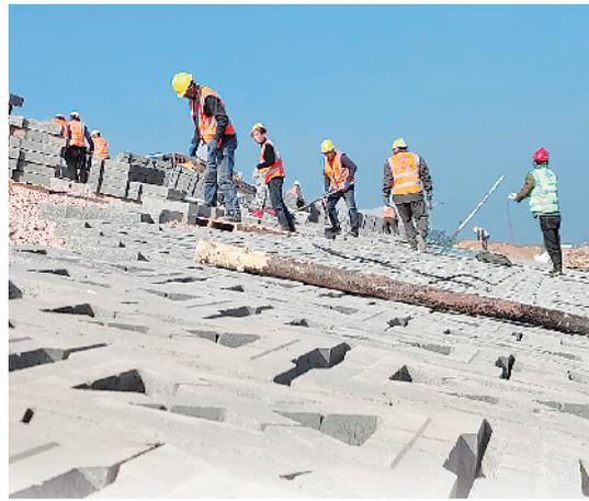
工人在周口港中心作业区退建大堤铺设护坡砖。
