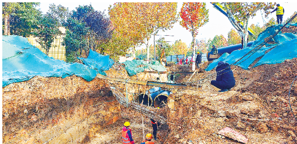
周口大道与文昌大道交会处集中供暖管网施工现场。
