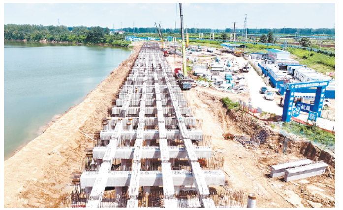
在建的周钢码头停泊位
