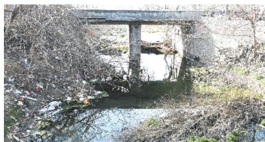
郸城县城郊乡皇姑桥220国道西河沟边有陈年垃圾,沟边有一处家禽宰杀点,周边环境差,污水直排河沟内
