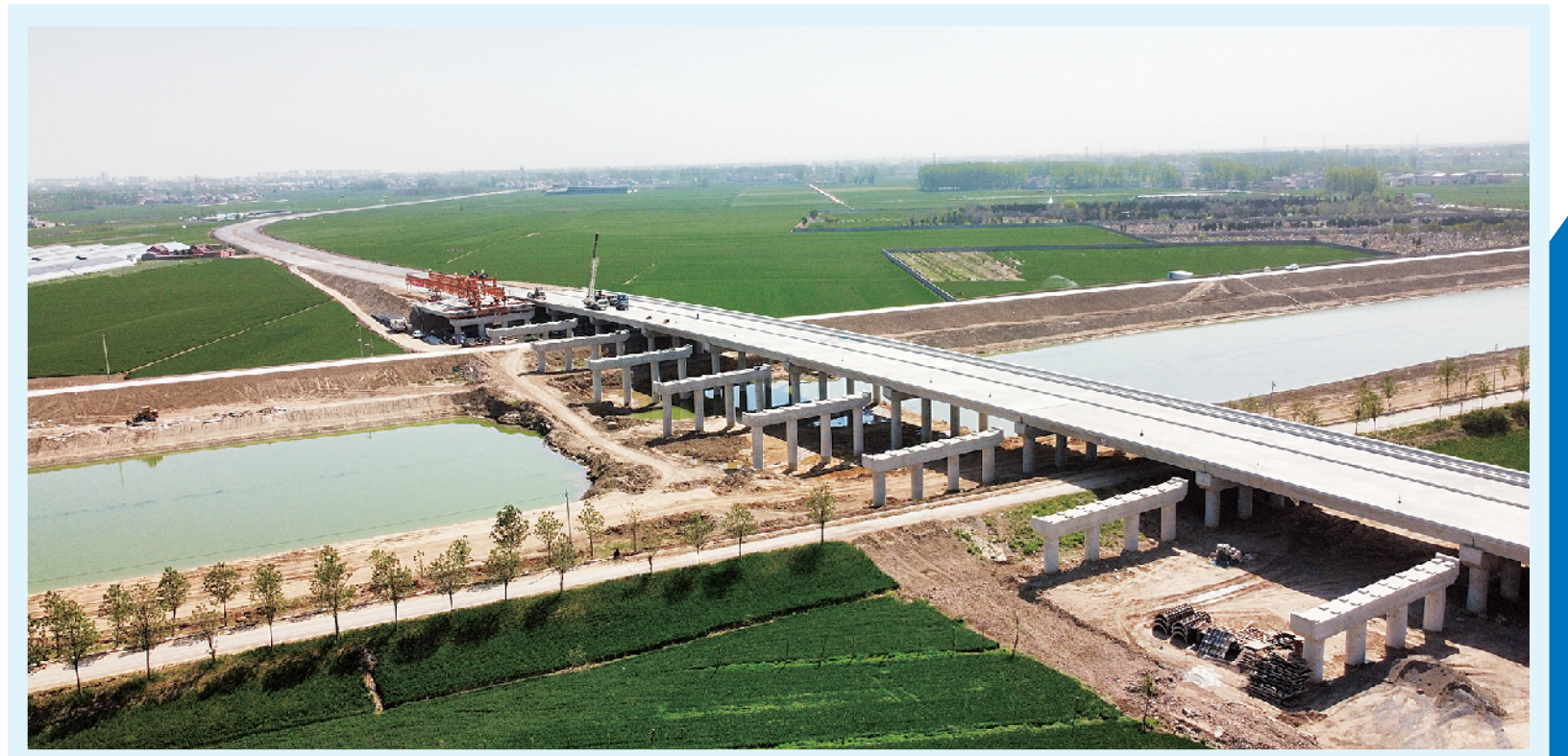
建设大道东延项目完工后,将有效改善周口市中心城区交通状况,提升城市形象,促进地方经济社会高质量发展。图为4月14日,正在紧张施工的建设大道东延项目新运河桥工程。 记者 刘俊涛 摄
