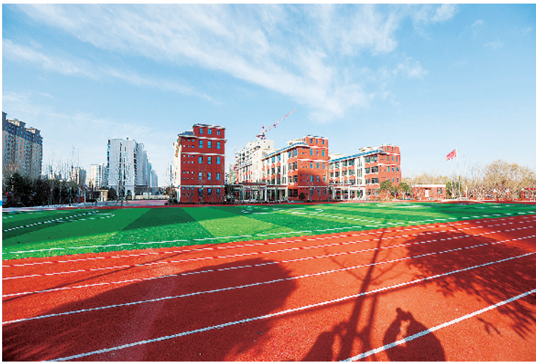
新建并投入使用的沈丘县树人小学。
