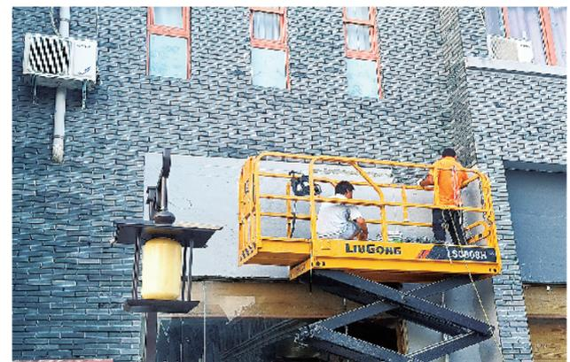
8月16日,两名工人在关帝庙历史街区进行复古墙砖施工。按照改造提升工程修旧如旧的原则,墙面施工后整个街区将更加协调美观。记者 沈湛 摄
