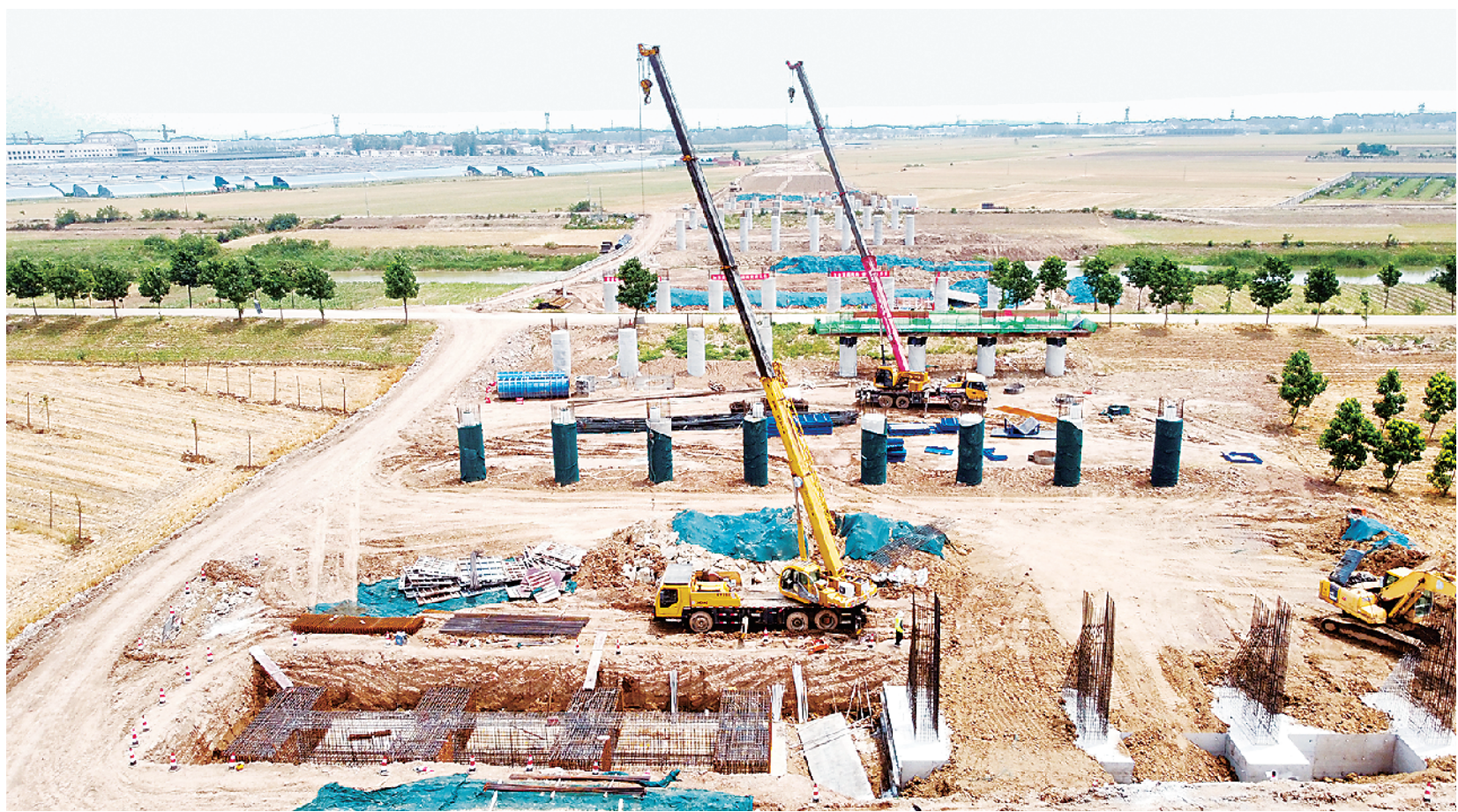
作为完善中心城区路网、改善交通环境的重要基础设施项目,建设大道东延工程进展情况受到我市群众广泛关注。据介绍,按照科学施工、精细管理的要求,该工程目前进展顺利。图为6月18日,建设大道东延工程新运河大桥施工现场。 记者 刘俊涛 摄
