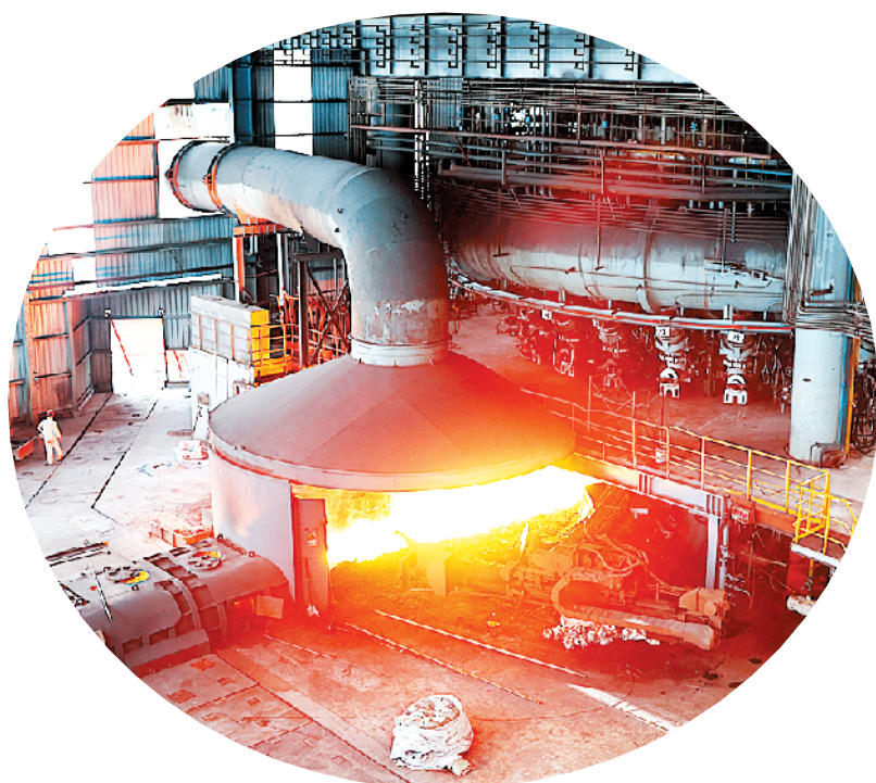
正在冶炼铁水的钢厂高炉。 记者 刘俊涛 摄
