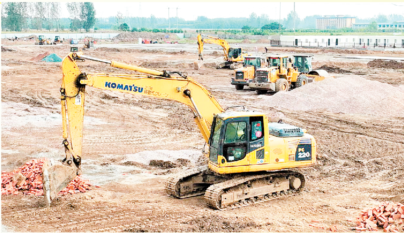
9月18日,在鑫丰生物经济产业园项目建设工地,机械轰鸣作响、运输车辆进出不断、人员穿梭忙碌,一派火热的施工景象。据了解,该项目开工以来,周口临港开发区全力以赴推动项目建设,确保项目尽早投产达效。 记者宋风 通讯员赵磊摄
