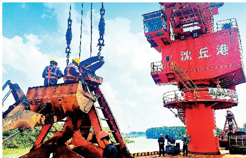
9月8日，沈丘港作业现场一瞥。据介绍，在“以港建区、以区促港、港产联动”的良好发展格局下，沈丘港为加快发展临港经济、打造钢铁新城发挥了重要作用，为周口建设国家区域中心城市港口城市提供了重要支撑。 记者 沈湛摄
