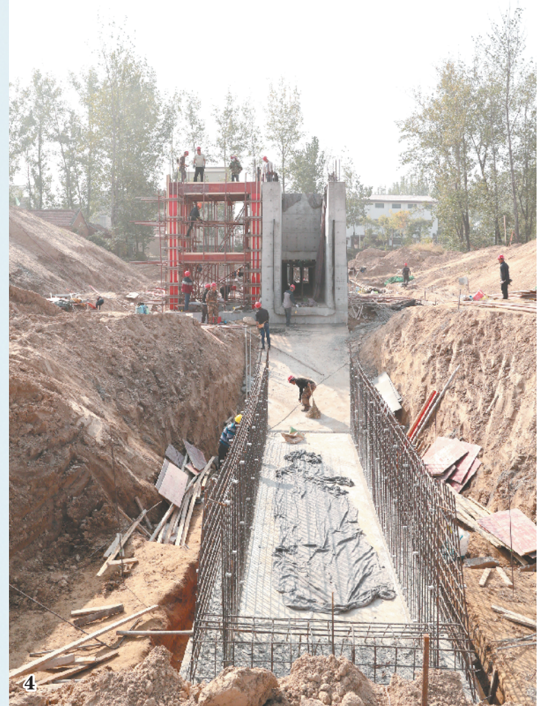
图1:工人们正在整修河堤。 图2:中心城区一处重点坡堤已建成成型。 图3:气势恢宏的拦河闸。 图4:贾鲁河一处正在施工的涵洞。 图5:贾鲁河重要坡堤用生态石笼网进行护坡,在提高河堤抗风抗氧化能力的同时,增加美观性。 图6:新的大闸建成后,扶沟县贾鲁河北关6孔闸也完成了历史使命。 图7:扶沟县贾鲁河北关闸,始建于1958年,共计17孔,1974年扩建6孔闸。2022年2月16日,旧的17孔贾鲁河北关闸进行了拆除,新建的北关大闸实行桥闸分离,拟于2023年5月底建成通车。 图8:正在建设中的西华县阎岗闸。 图9:在生态石笼网护坡施工中,笼网内的大小石块需要人工一块一块堆砌。 图10:涵洞建成后,汛期与河道堤防和排水蓄水工程配合,充分发挥控制水流的作用。
