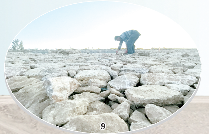
图1:工人们正在整修河堤。 图2:中心城区一处重点坡堤已建成成型。 图3:气势恢宏的拦河闸。 图4:贾鲁河一处正在施工的涵洞。 图5:贾鲁河重要坡堤用生态石笼网进行护坡,在提高河堤抗风抗氧化能力的同时,增加美观性。 图6:新的大闸建成后,扶沟县贾鲁河北关6孔闸也完成了历史使命。 图7:扶沟县贾鲁河北关闸,始建于1958年,共计17孔,1974年扩建6孔闸。2022年2月16日,旧的17孔贾鲁河北关闸进行了拆除,新建的北关大闸实行桥闸分离,拟于2023年5月底建成通车。 图8:正在建设中的西华县阎岗闸。 图9:在生态石笼网护坡施工中,笼网内的大小石块需要人工一块一块堆砌。 图10:涵洞建成后,汛期与河道堤防和排水蓄水工程配合,充分发挥控制水流的作用。
