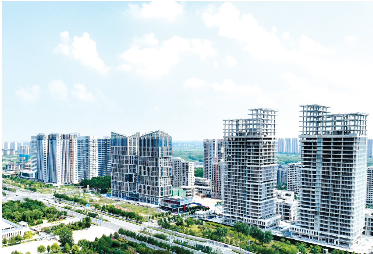
建设中的行政片区
