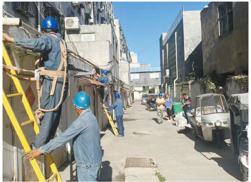
供电公司作业人员正在拆除凌乱的“飞线”
