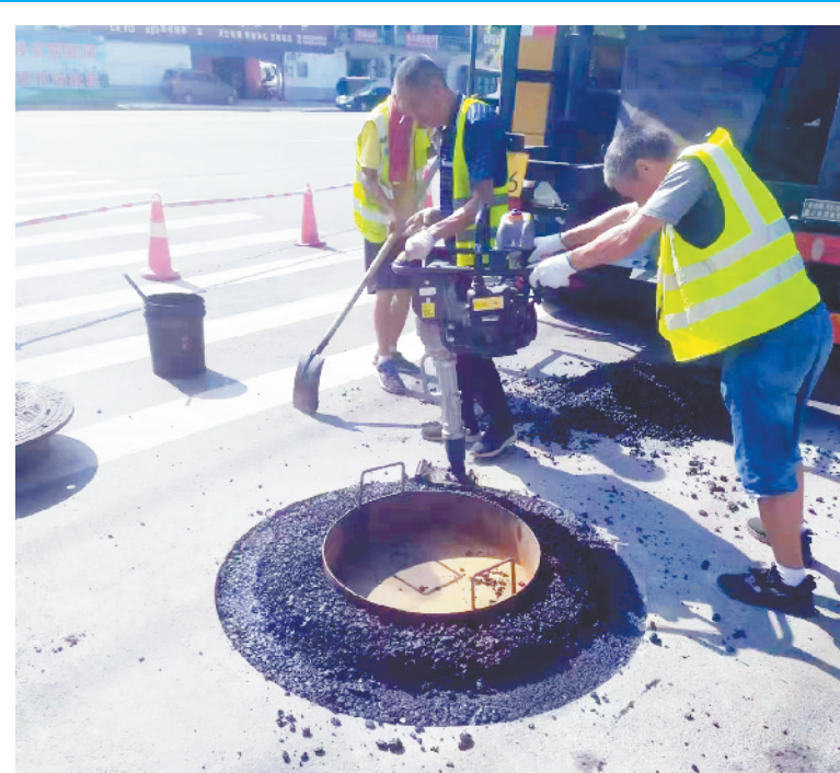
汛期来临,开发区市政部门加强对辖区道路窠井盖巡查和管理,对出现问题的窠井盖进行修复和更换。 记者 王晨 摄
